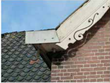
11.3 windveren en overstekken, zuidzijde
