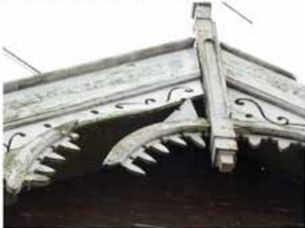
11.3 windveren en overstekken, noordzijde
