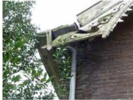
11.3 windveren en overstekken, noordzijde
