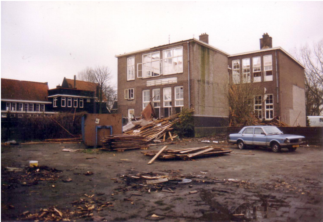
Sloop van het schoolgebouw: lokaal 1 (boven) en 6 (beneden).
