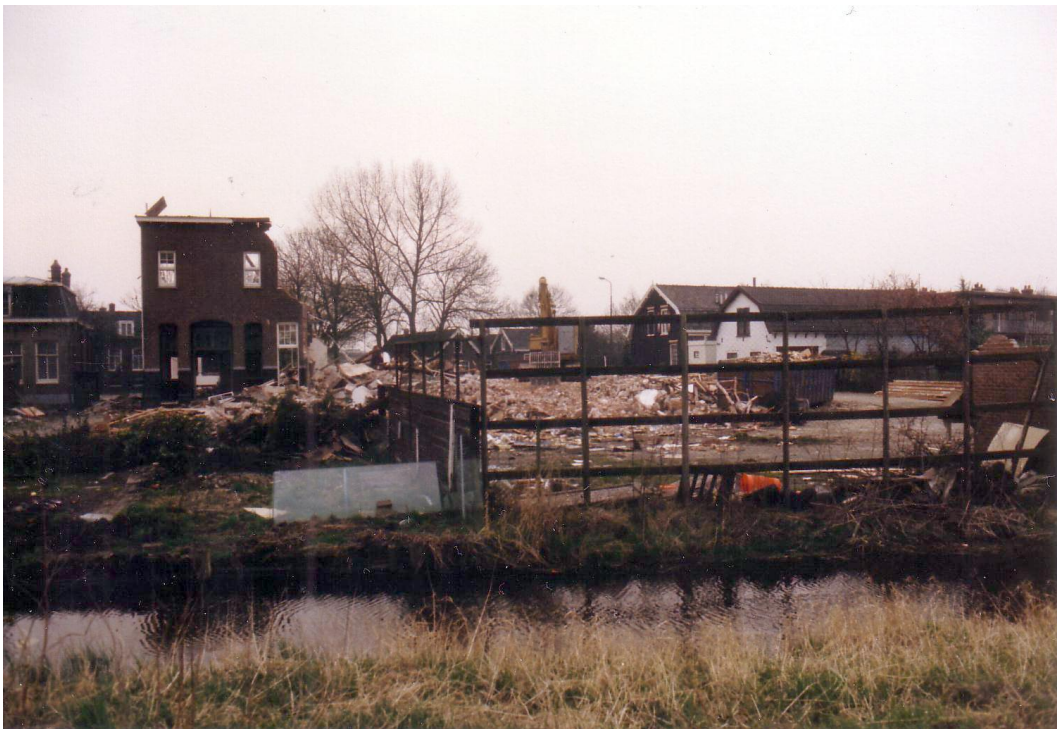
Overzichtsfoto van de sloop vanaf de weilanden achter de speelplaats. Ook van het klooster staat nog maar een klein deel.
