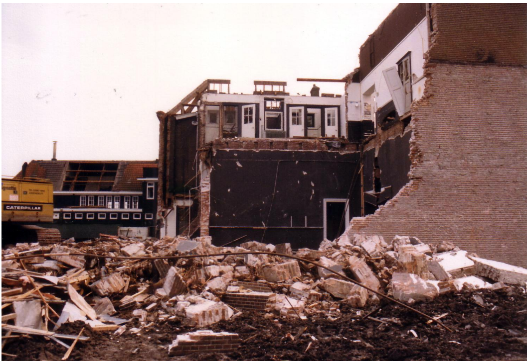
Sloop van het schoolgebouw: (lokaal 2 boven + toiletgang) en lokaal 3 (beneden) Op de achtergrond is ook de sloop van het St. Willibrordusgebouw al gestart.
