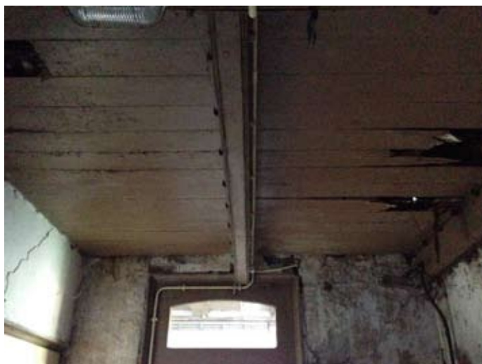
20.2 zoldervloer boven hal, vloerplanken
