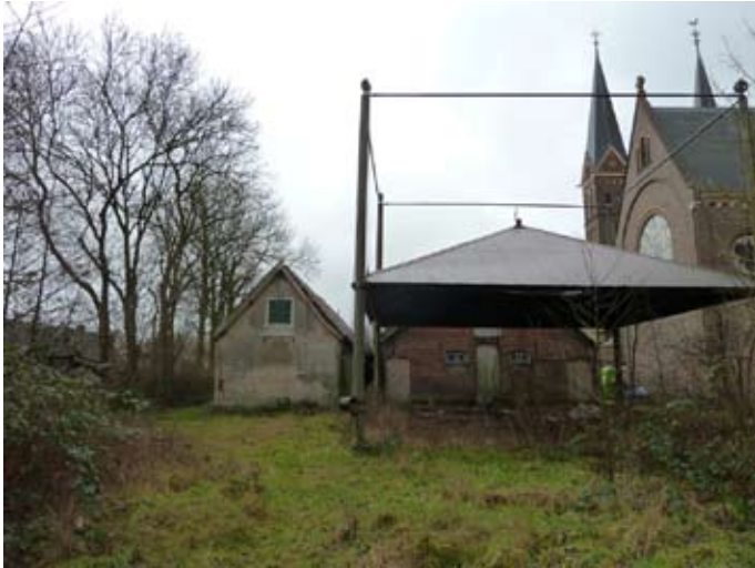
44.1 kapberg met betonnen roeden en stalen dak
