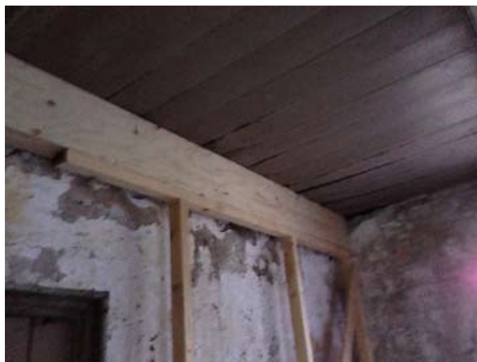
20.2 zoldervloer boven hal, vloerplanken
