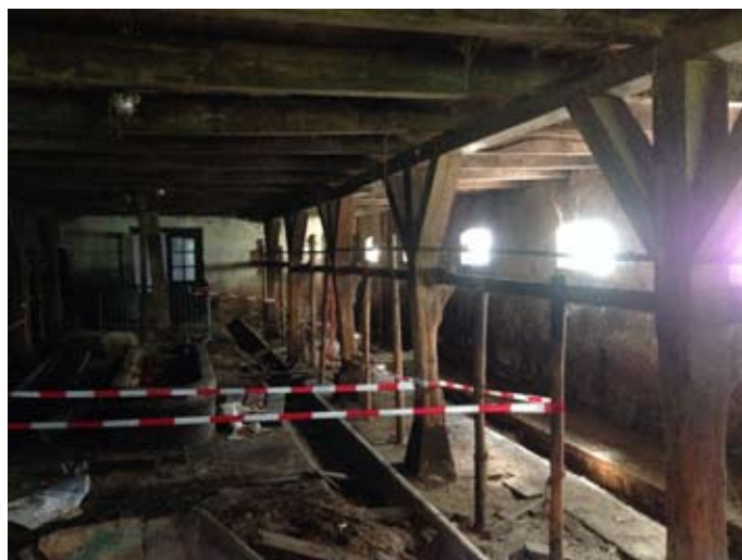
20.3 zoldervloer boven stal, staanders en vloerbalken
