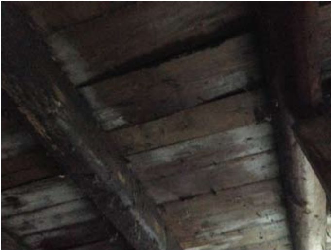
21.1 vloer boven paardenstal, vloerbalken en planken
