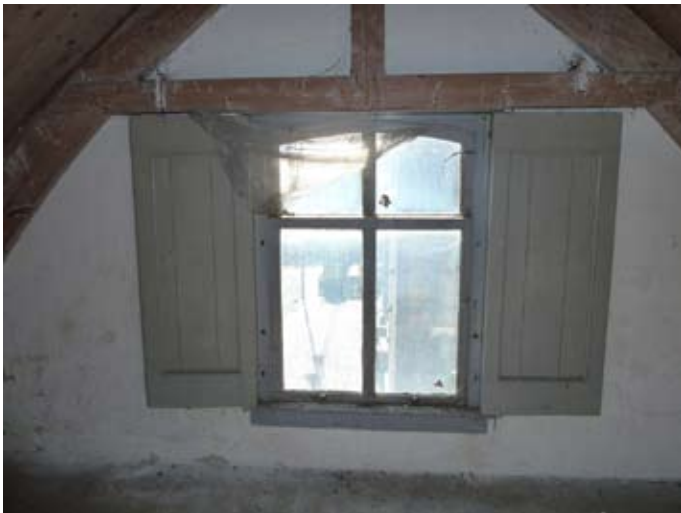
28.1 zuidgevel zolder voorhuis
