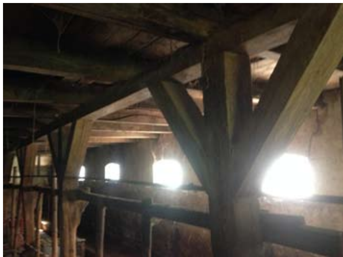
20.3 zoldervloer boven stal, staanders en vloerbalken
