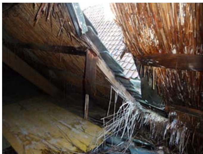
23.2 dakbeschot met riet onder de pannen
