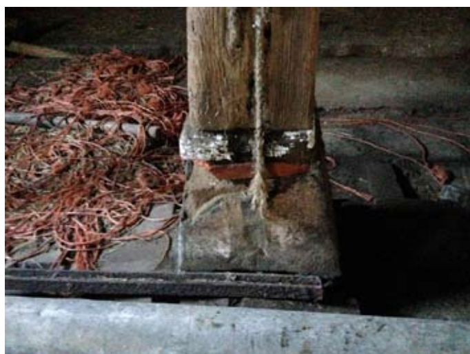
20.3 zoldervloer boven stal, staanders en vloerbalken
