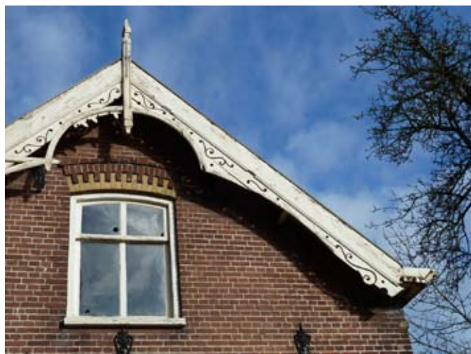
11.3 windveren en overstekken, zuidzijde
