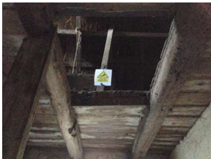
21.1 vloer boven paardenstal, vloerbalken en planken
