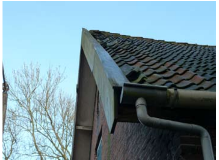
12.3 windveren en dakoverstekken, westzijde
