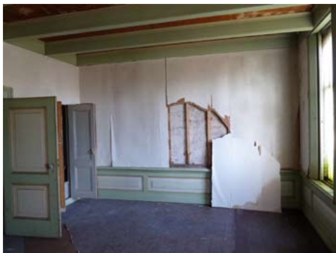
26.5 kamer 2 aftimmeringen gevel
