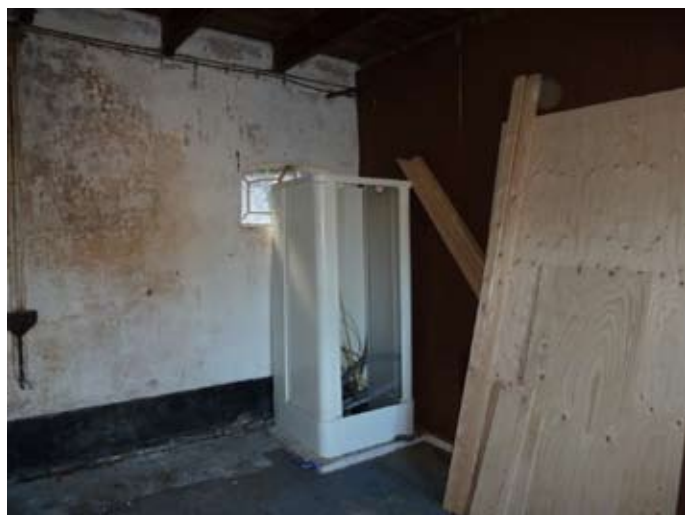
33.8 tussenwand en douche (slopen)
