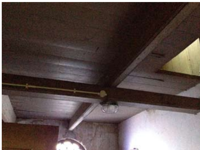
20.1 zoldervloer boven hal, vloerbalken
