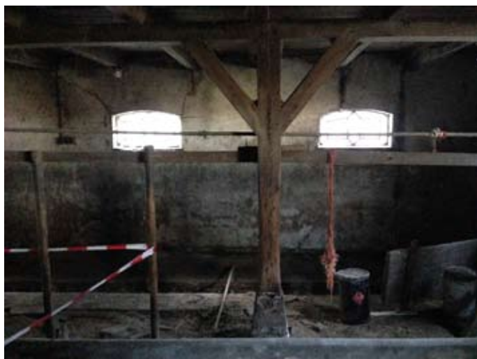
20.3 zoldervloer boven stal, staanders en vloerbalken
