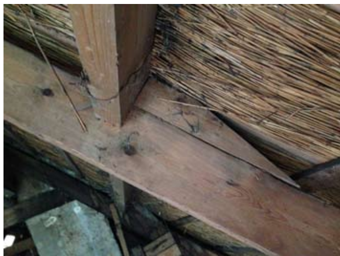
24.2 dakbeschot met riet onder de pannen
