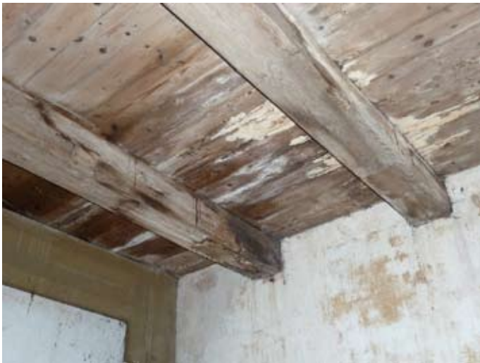
21.2 zoldervloer boven wagenstalling, vloerbalken
