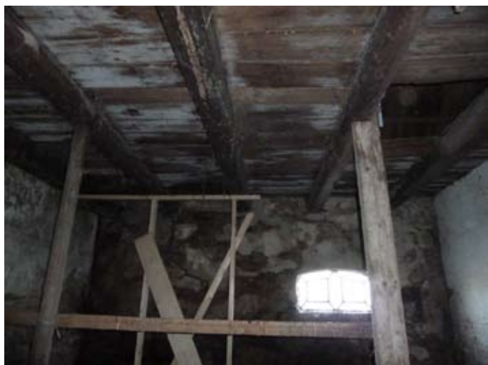
21.1 vloer boven paardenstal, vloerbalken en planken
