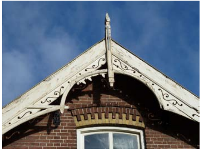
11.3 windveren en overstekken, zuidzijde
