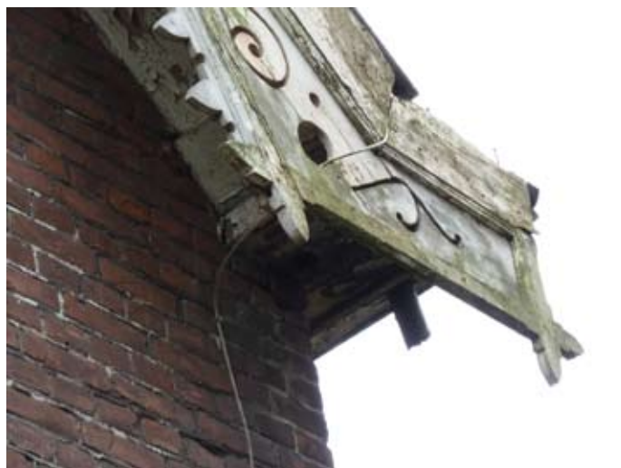
11.2 dakgoot, noord-westzijde voorhuis
