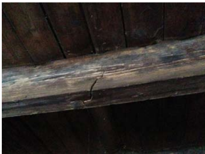
20.3 zoldervloer boven stal, staanders en vloerbalken
