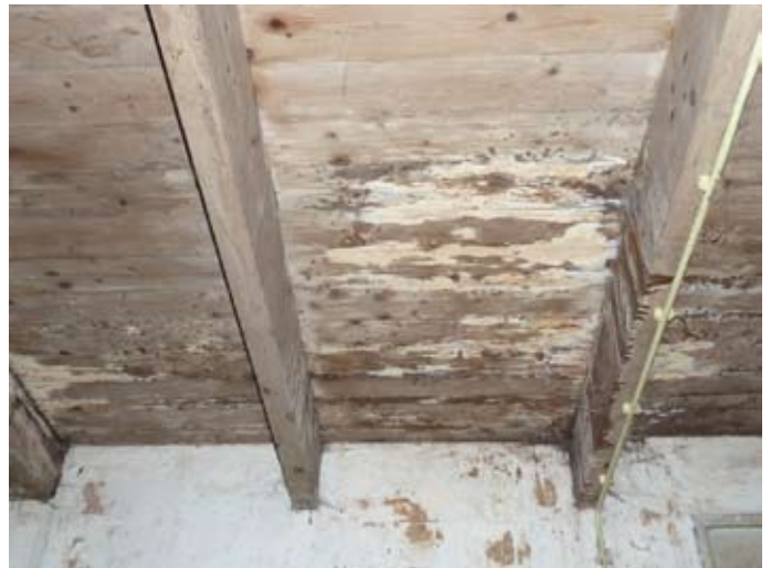
21.2 zoldervloer boven wagenstalling, vloerplanken
