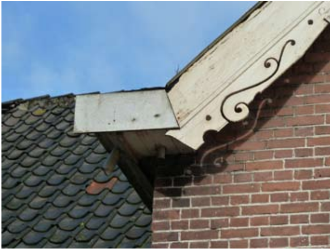
11.3 windveren en overstekken, zuidzijde
