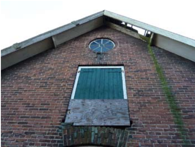
12.3 windveren en dakoverstekken, westzijde
