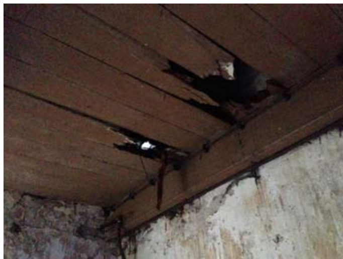
20.2 zoldervloer boven hal, vloerplanken
