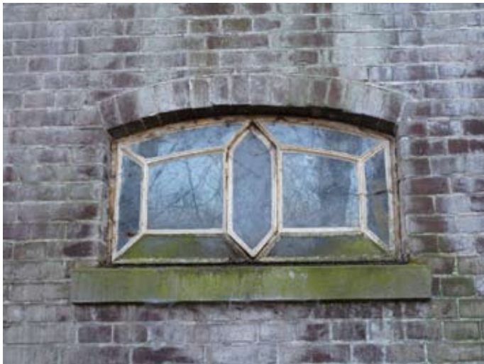
4.6 stalraam wagenstalling
