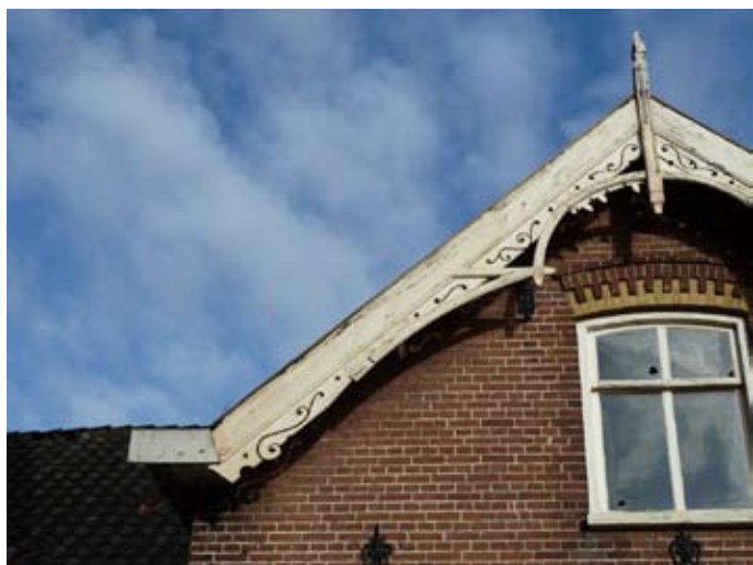
11.3 windveren en overstekken, zuidzijde
