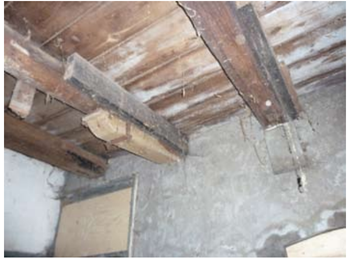
21.1 vloer boven paardenstal, vloerbalken en planken
