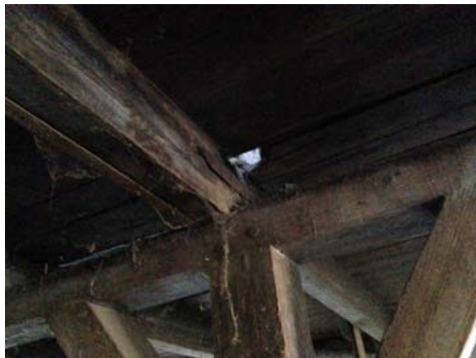
20.3 zoldervloer boven stal, staanders en vloerbalken
