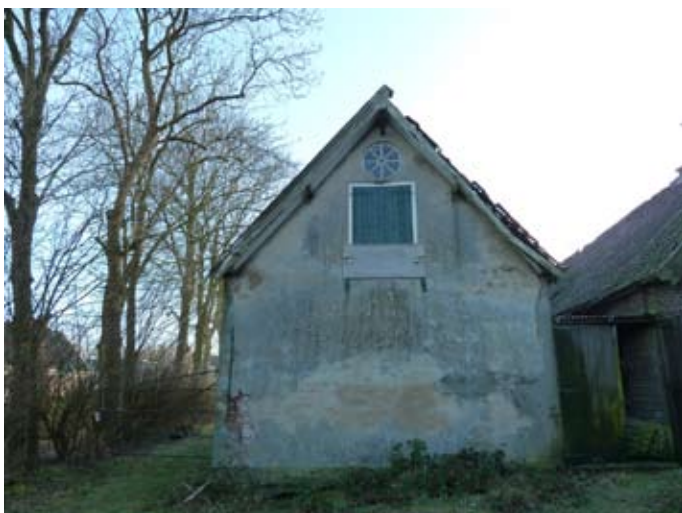
5. achtergevel zomerhuis (west)
