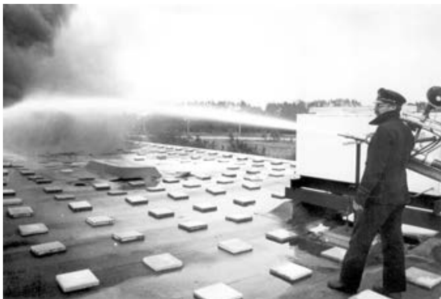
Brandweer- Commandant Ouder-Amstel Paul Sloven aan het werk op het dak van de Makro.
