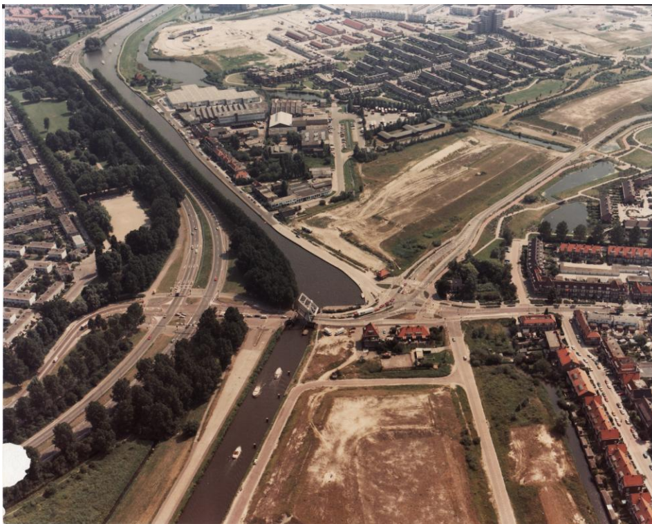
Betondorp, Weespertrekvaart, Duivendrechtsebrug, Molenkade, Rijksweg Noord, Kloosterstraat, Berkenstraat, Populierstraat
