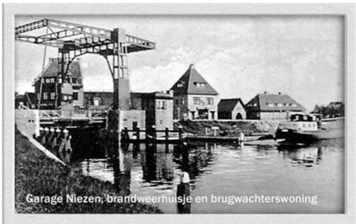
Overzicht met garage Niezen. Café Zomerlust is in de hoogte uitgebreid Foto van de dia van B.P.Hess
