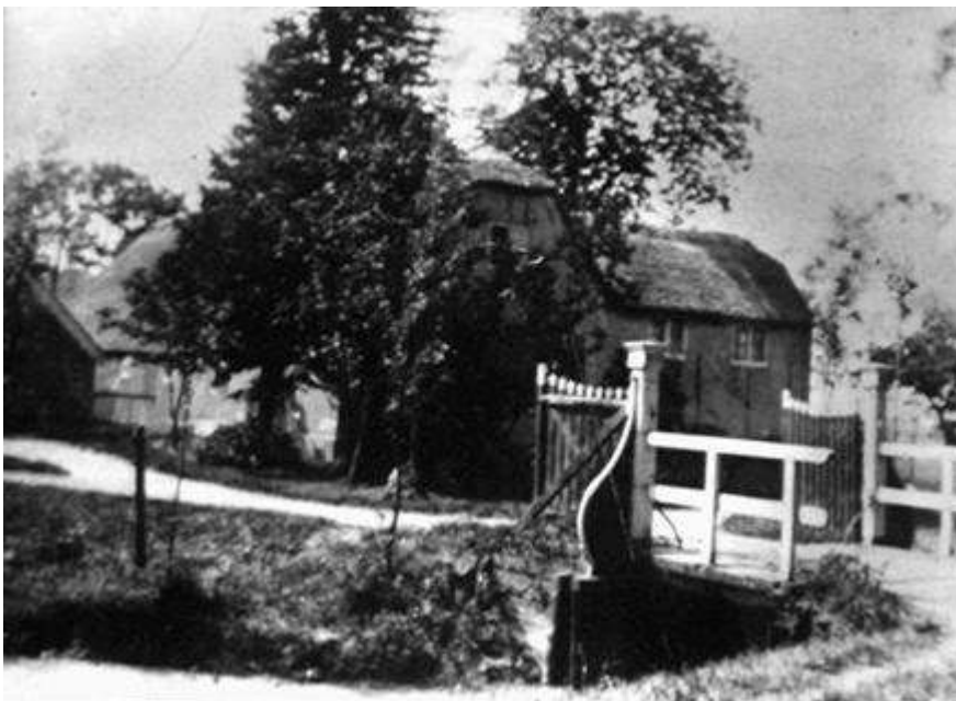
Weltevrede , een 17 de eeuwse boerderij, was de tweede boerderij rechts na de Duivendrechtse brug, Nu hoek Kloosterstraat – Rijksstraatweg tegenover Brugzicht.. Weltevrede werd bewoond door de familie Koekenbier en is in 1925 gesloopt..
